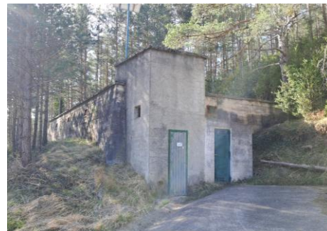
Depósito principal de 420.000 litros de capacidad.
