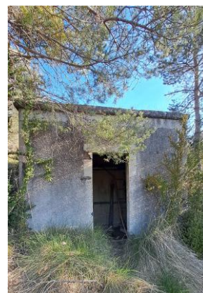
Depósito antiguo, próximo a la Iglesia de San Esteban, de 50.000 litros de capacidad.
