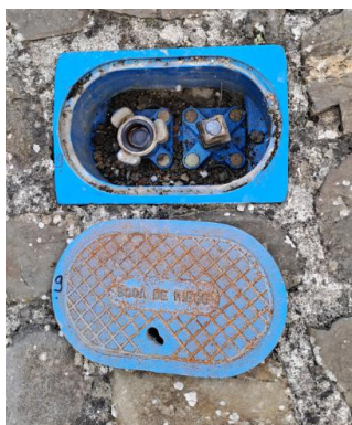
Boca de Riego con salida racor Barcelona de 45 mm y llave de cierre de estrella.
